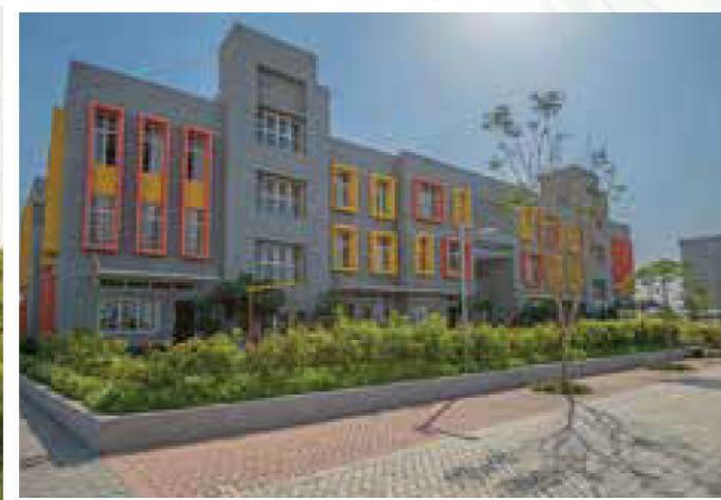
Actual site photographs
